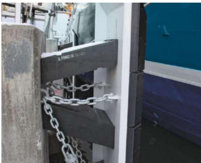
I fender modulari "Unit Element" sono assemblabili in svariate soluzioni.
