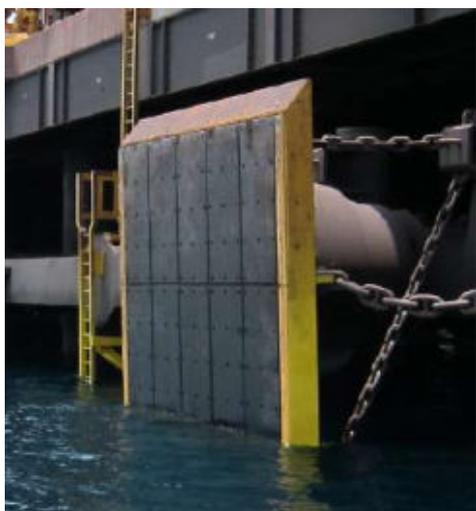
Il **PE-UHMW**, polietilene ad altissimo peso molecolare, è diventato il materiale di scelta per i rivestimenti dei pannelli frontali in acciaio dei fender, dove è richiesta la combinazione di altissima resistenza agli urti e all'abrasione, con un basso attrito del pannello.
